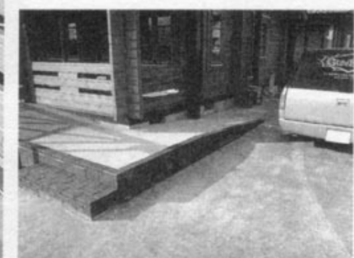
左/駐車場から延びるスロープ。幅約100cm。上/来訪者はこの角から上がる
